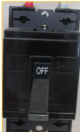
ภาพแสดงการเปิด “OFF” สวิตช์เบรกเกอร์เครื่องฉายโปรเจคเตอร์
